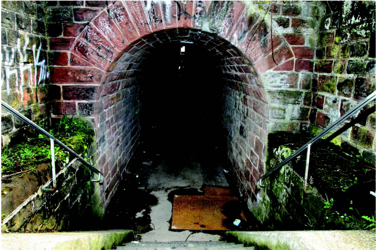
Abbildung: Bahnunterführung "Am Tunnel / Parallelweg"
