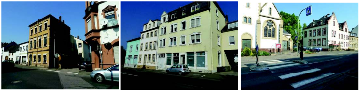
Abbildung: Sanierungsbedürftige Häuser und Umfeld der evangelische Kirche
