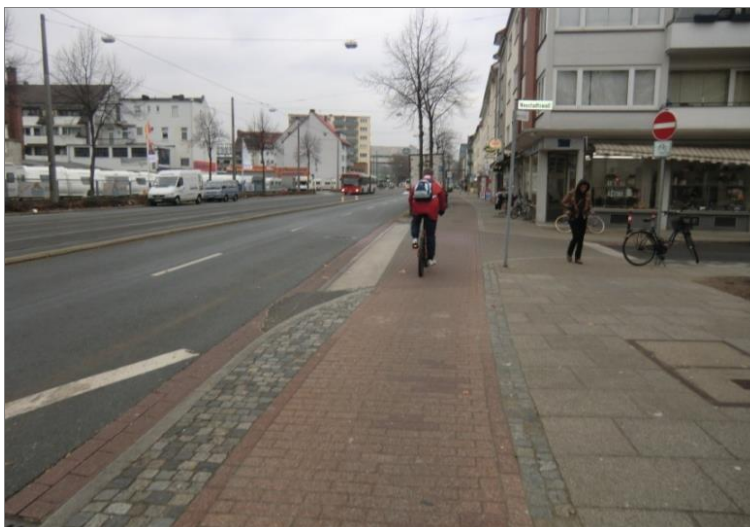
Abb. 5-17: Teilaufpflasterung im Einmündungsbereich einer Nebenstraße (Bremen)
