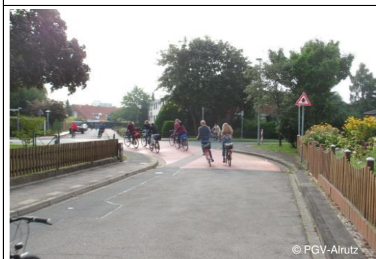
Beispiel Burgdorf (links) und Mannheim (rechts) Bevorrechtigung an Einmündungen im Zuge einer Fahrradstraße durch flächige Markierung und Vz 301 StVO
