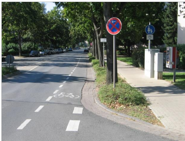
Abb. 5-12: Kombination von Schutzstreifen mit Gehweg, Radverkehr frei (Hameln)
