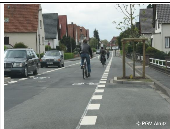
Beispiel Lemgo Fahrgasse (3,5-4 m breit) mit Breitstrichmarkierung (1 m Strich, 1 m Lücke); punktuelle Gehwegnasen zur Unterbrechung des linearen Parkens am Fahrbahnrand
