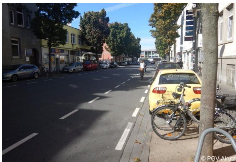
Abb. 5-10: Schutzstreifen mit Sicherheitstrennstreifen zu parkenden Kfz (Hildesheim)
