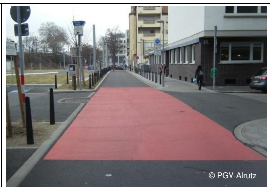
Beispiel Burgdorf (links) und Mannheim (rechts) Bevorrechtigung an Einmündungen im Zuge einer Fahrradstraße durch flächige Markierung und Vz 301 StVO
