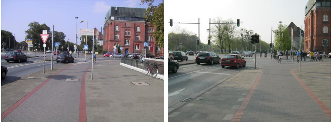
Abb. 5-20: Rückbau und Signalisierung eines konfliktträchtigen freien Rechtsabbiegefahrstreifens in Hannover (links vorher, rechts nachher)
