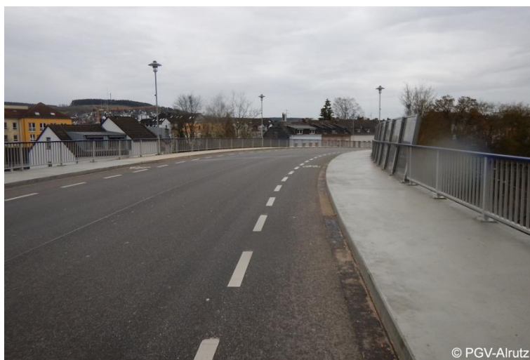
Abb. 5-11: Schutzstreifen auf Gleisbrücke Granstraße
