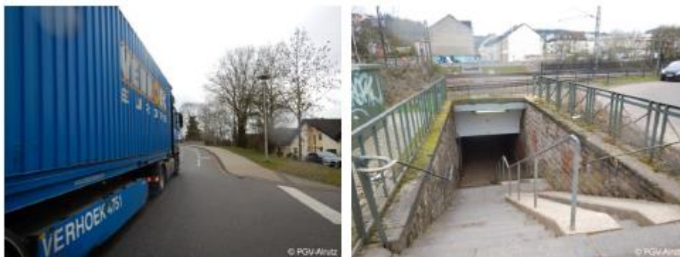
Abbildung 4: Die Schutzstreifen auf der Granabrücke entsprechen nicht dem heutigen Stand der Technik; der Konstatintunnel hat steile Treppen und Schieberampen und ist zu eng ausgebildet (Angstraum)
