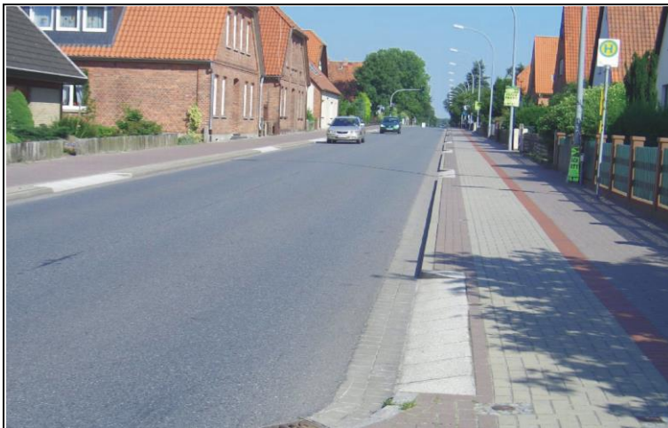
Abb. 5-3: Grundstückszufahrten mit Rampenstein (Soltau)
