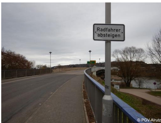
Konzerbrück Unzureichende Breite des Seitenraumes, Radfahrer absteigen
