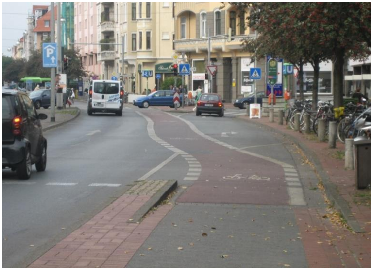
Abb. 5-18: Übergang Radweg in Radfahrstreifen an signalisiertem Knotenpunkt (Hannover)
