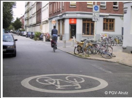
Beispiel Kiel Fahrradstraßen mit Fahrbahnrandmarkierung und großem Piktogramm an allen Knotenpunkten
