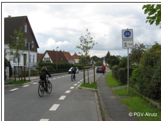
Beispiel Lemgo Fahrgasse (3,5-4 m breit) mit Breitstrichmarkierung (1 m Strich, 1 m Lücke); punktuelle Gehwegnasen zur Unterbrechung des linearen Parkens am Fahrbahnrand
